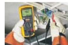
Test kabeláže v malé rozvodné skříně – vše v jednom bodě
