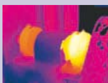
Nevyrovnané zatížení třífázového rozvaděče
