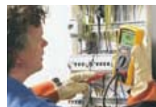
Test izolace na deskovém rozvaděči
